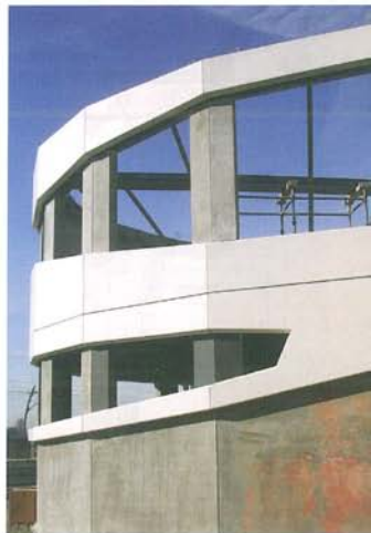
Glas is structureel verlijmd op betonstijlen
