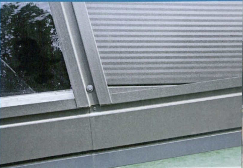
Complexe aansluitingen tussen glaspanelen, iso-panelen en stroken polycarbonaat
