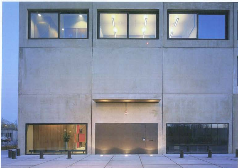
2 | De eindgevelelementen van de langsgevel en van de kopgevel steken beurtelings door
