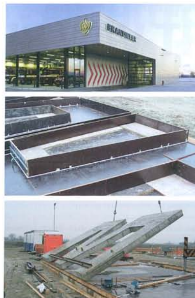
7 | De centerpengaten van de westelijke wand vallen samen met de beschildering van rode pijlen
