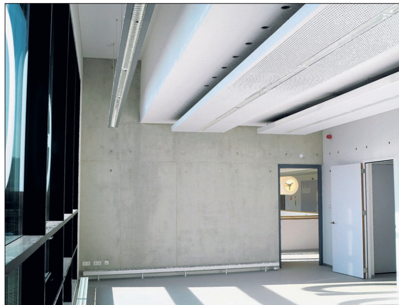
Betonkernactivering: Gaten in het plafond van een klaslokaal zorgen voor ventilatie waardoor het er 's zomers koel is en 's winters warm.
