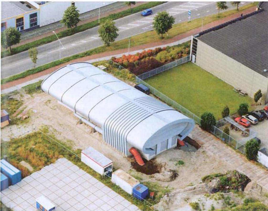
3 | Booster Noord is als eerste dit voorjaar in gebruik genomen.
