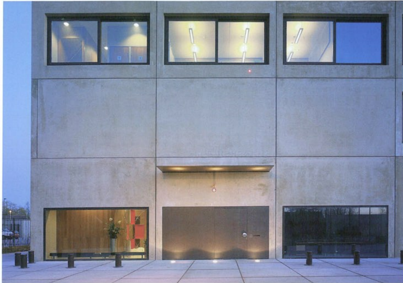
2 | De eindgevelelementen van de langsegevel en van de kopgevel steken beur- telings door
